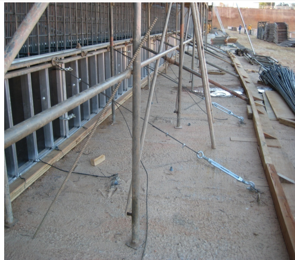
Foto 16 – Forma/Ferragem/Concreto – Muro de Arrimo Eixo 1
