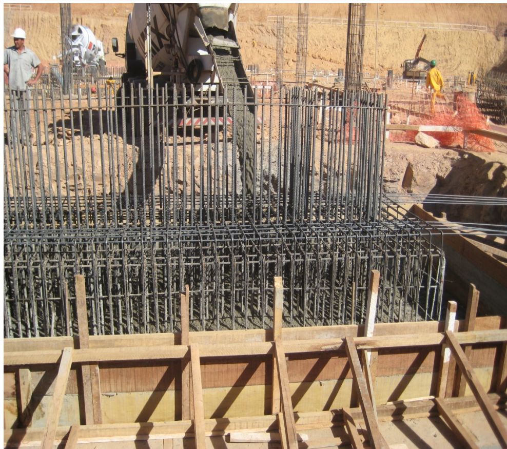
Foto 17 – Forma/Ferragem/Concreto – Sapata Trecho V
