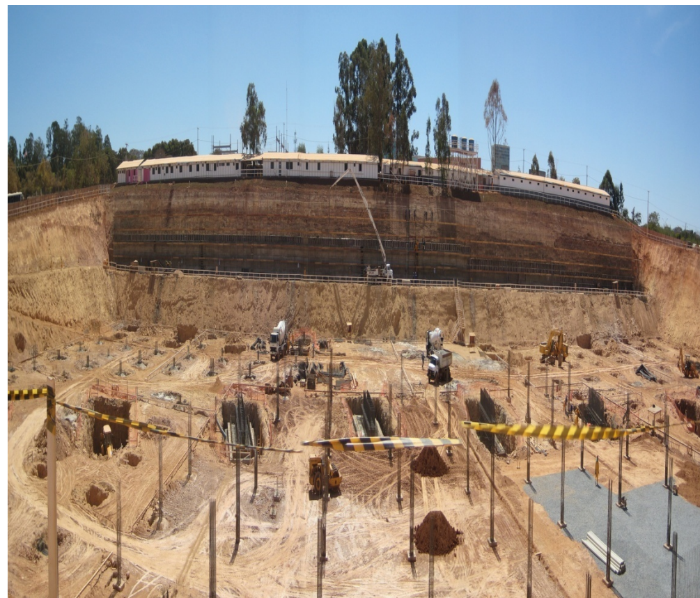
Foto 2 – Vista geral das instalações do canteiro e da obra
