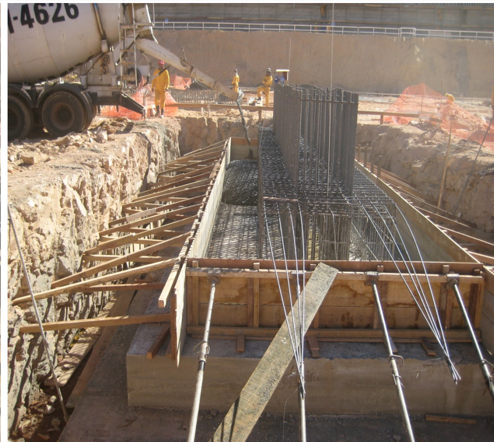
Foto 18 – Forma/Ferragem/Concreto – Sapata Trecho V
