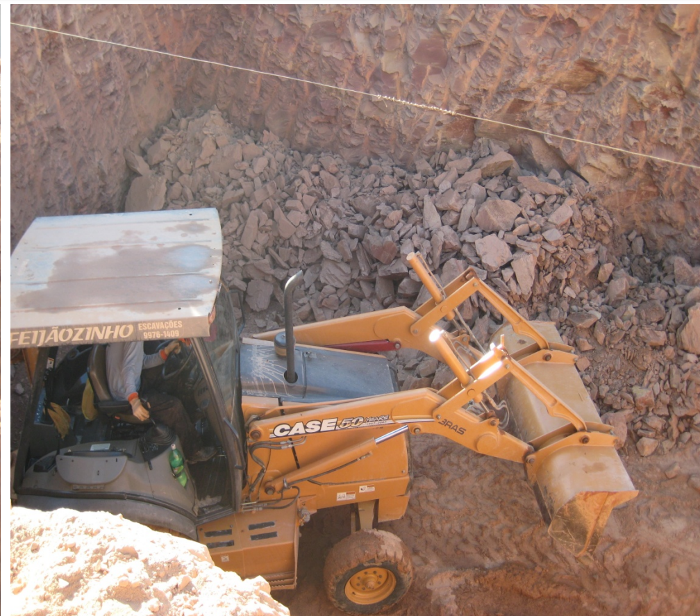
Foto 12 – Escavação Sapatas Trecho V
