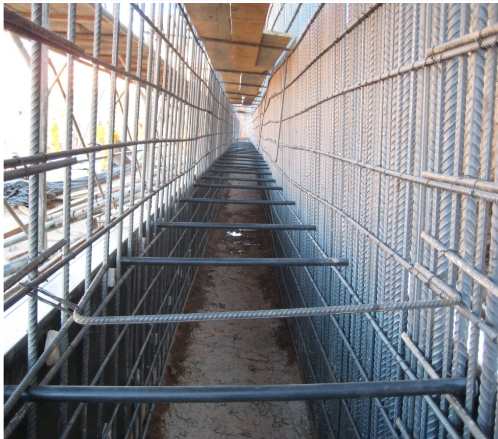
Foto 13 – Forma/Ferragem Muro de Arrimo Eixo 1
