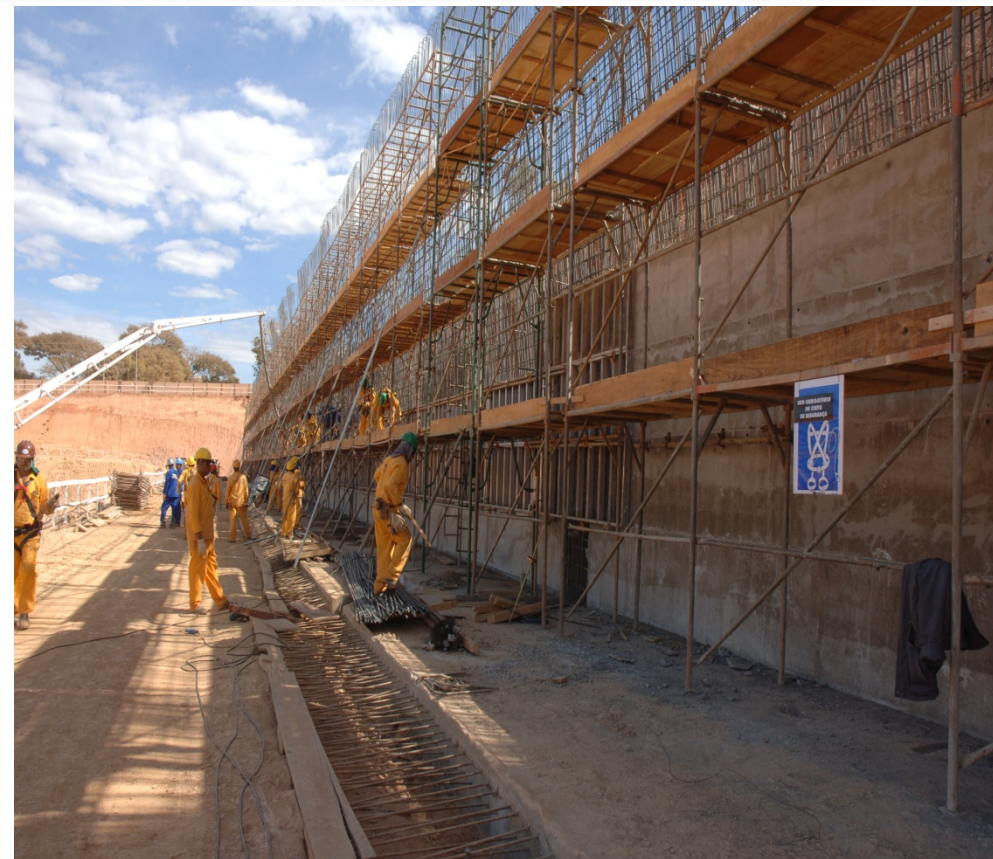
Foto 14 – Forma/Ferragem/Concreto – Muro de Arrimo Eixo 1
