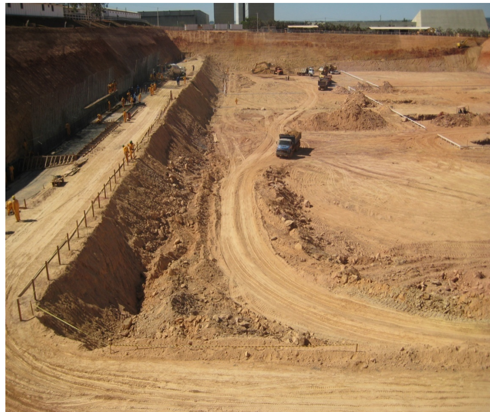
Foto 8 – Terraplenagem – Transporte, lançamento e espalhamento de material escavado
