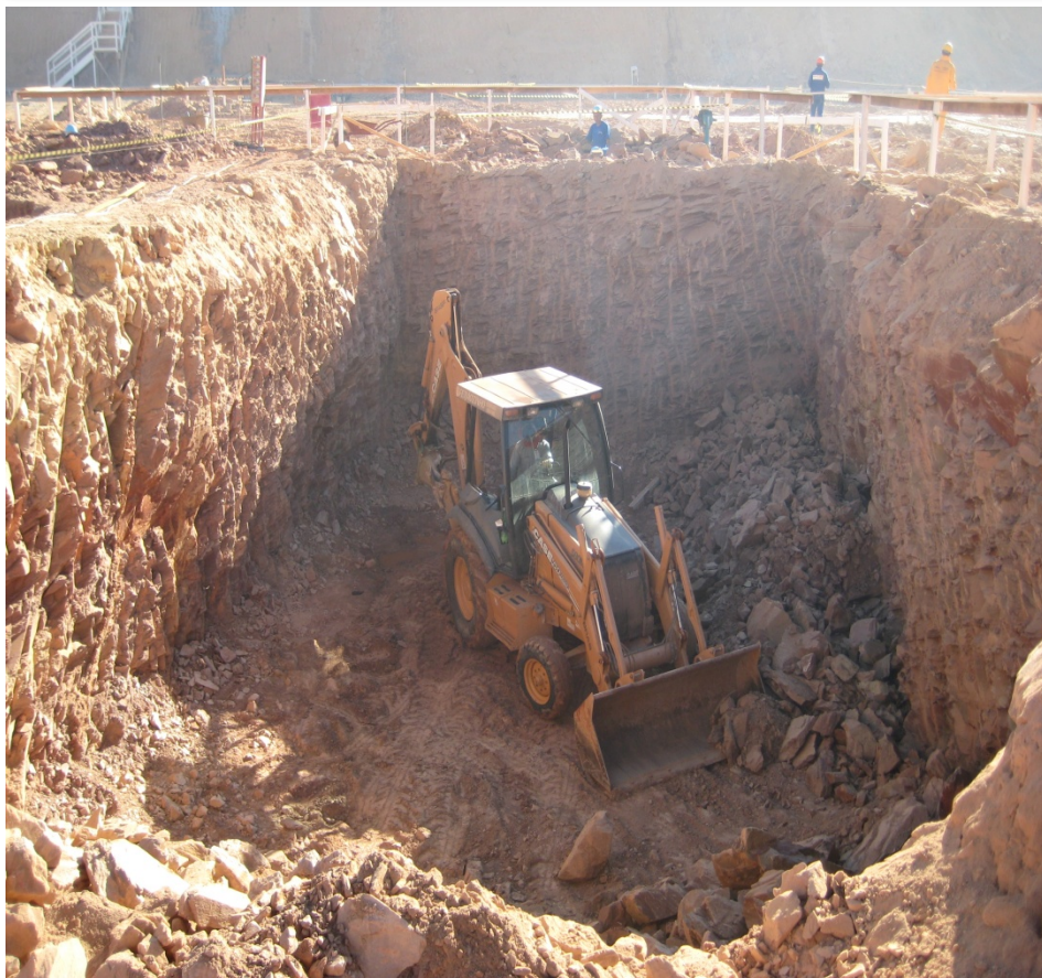
Foto 11 – Escavação Sapatas Trecho V
