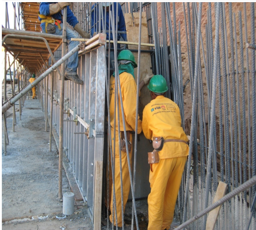
Foto 15 – Forma/Ferragem – Muro de Arrimo Eixo 1
