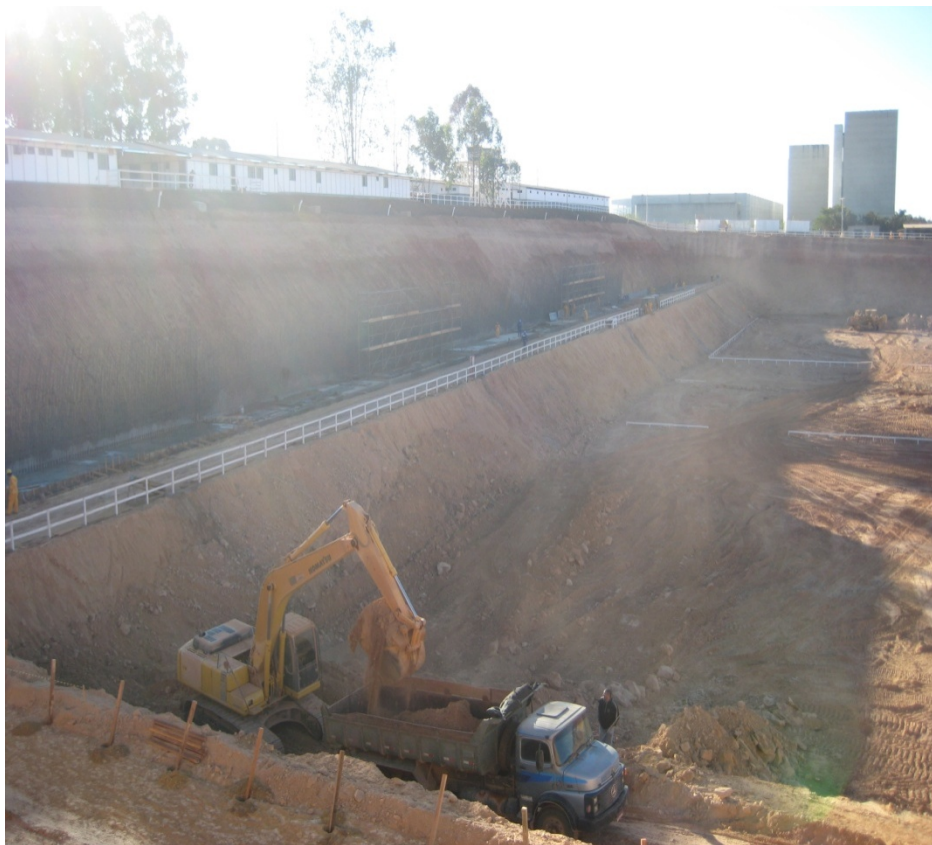
Foto 7 – Terraplenagem – Transporte, lançamento e espalhamento de material escavado
