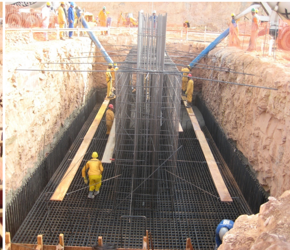
Foto 20 – Sapata Armada em fase de Concretagem Trecho V
